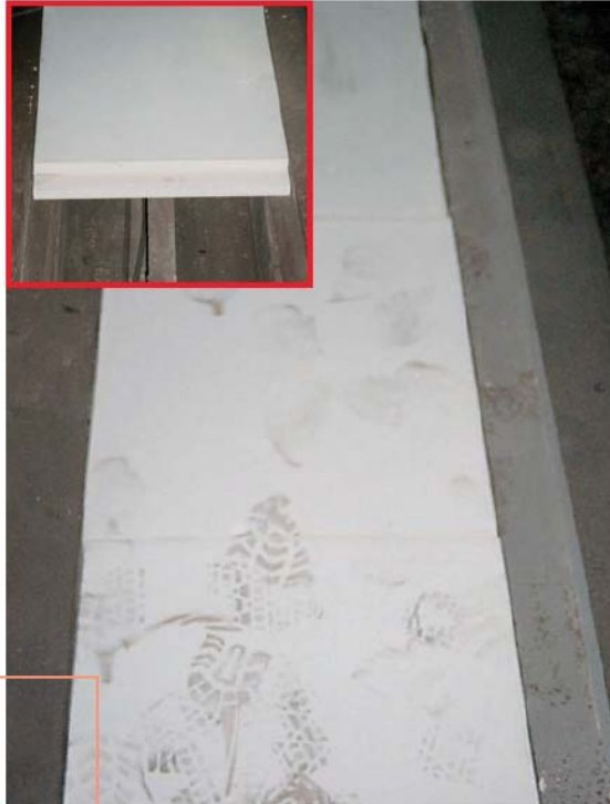
Recouvrement de caniveaux à câbles RER de Munich
