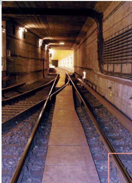
Recouvrement des traverses de chemins de fer Métro de Berlin
