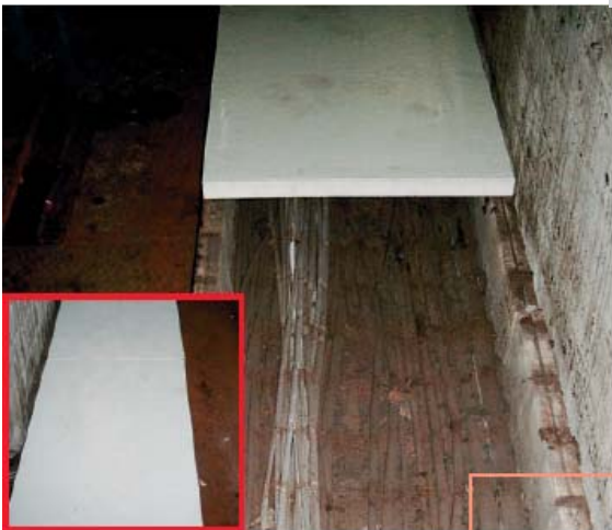
Recouvrement de caniveaux à câbles Métro de Nuremberg
