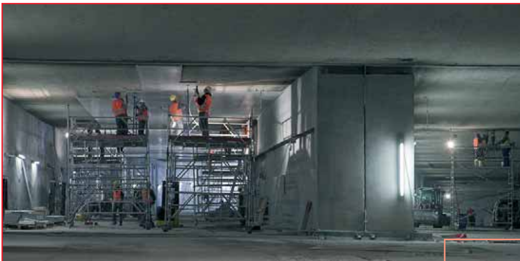
Tunnel de l'aéroport de Tegel Berlin
