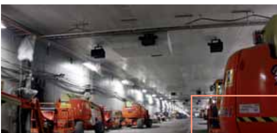
Tunnel de Söderleds
