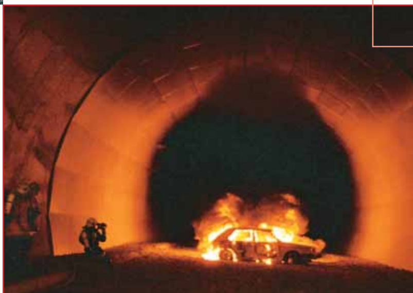
Tunnel des Bruyères Exercice d'incendie des pompiers Habillage du béton de construction dans la zone de l'exercice avec des plaques de protection contre le feu AESTUVER dicon tu
