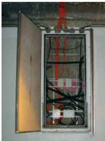
Couverture de puits F 90-A
