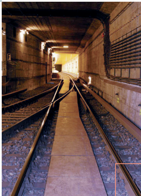
Holzbohlen- abdeckung, U-Bahn Berlin
