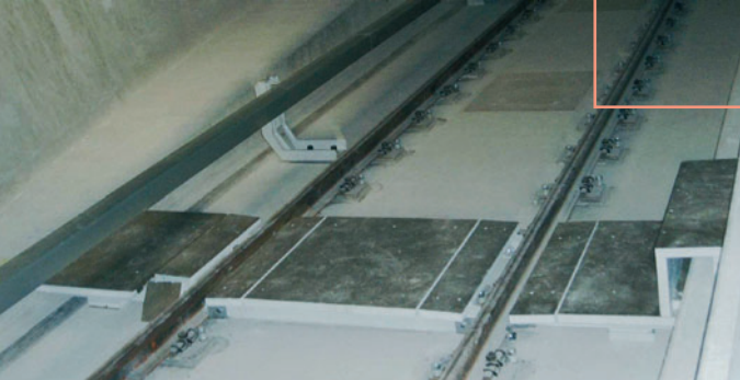
Wartungsweg, U-Bahn Fürth
